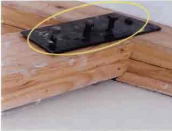
Fotografía N° 14: Detalle de fijación existente en encuentro de vigas.
